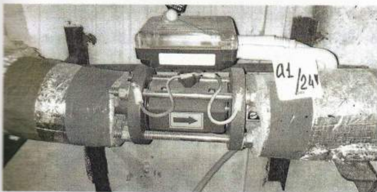
Рисунок 5. Преобразователь расхода «Взлёт ЭР» исп. ЭРСВ-470Л В/32.
